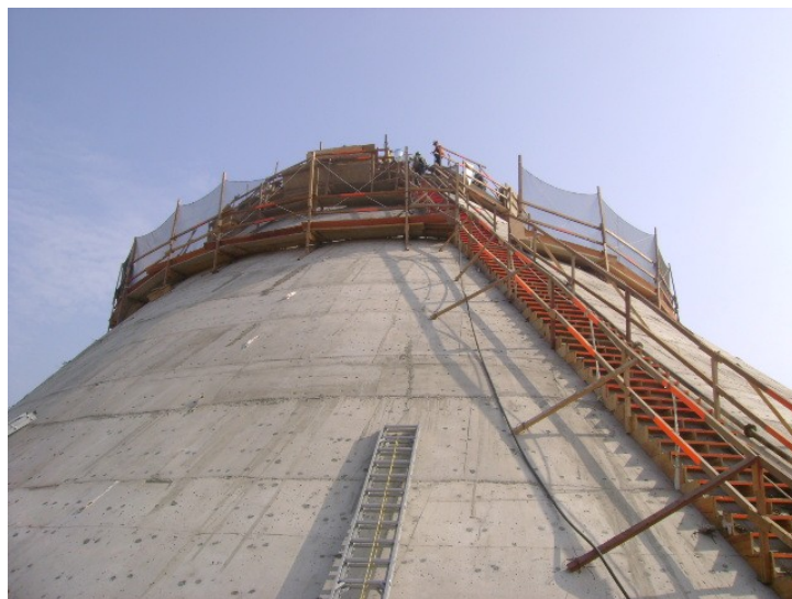
Vista desde la zona exterior. Se observa la escalera de acceso principal con sus respectivas barandas y línea de vida. También se observa una plataforma intermedia con malla de seguridad en caso de caídas.
