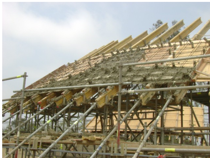
Fotos de la implementación de ensayos y prototipos de encofrado de cúpula.
