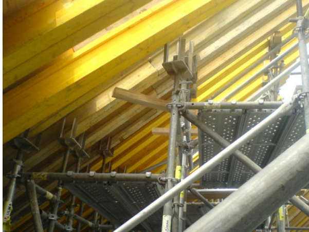
Vista interna del encofrado. Se implementaron plataformas rígidas de trabajo.
