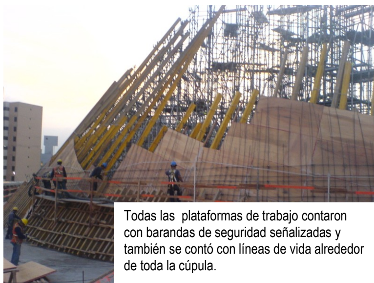
Vista desde la zona exterior. Se observa la escalera de acceso principal con sus respectivas barandas y línea de vida. También se observa una plataforma intermedia con malla de seguridad en caso de caídas.
